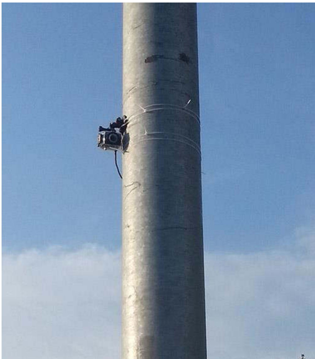
Рисунок 5 – Монтаж видеокамеры на столб линии электроосвещения
