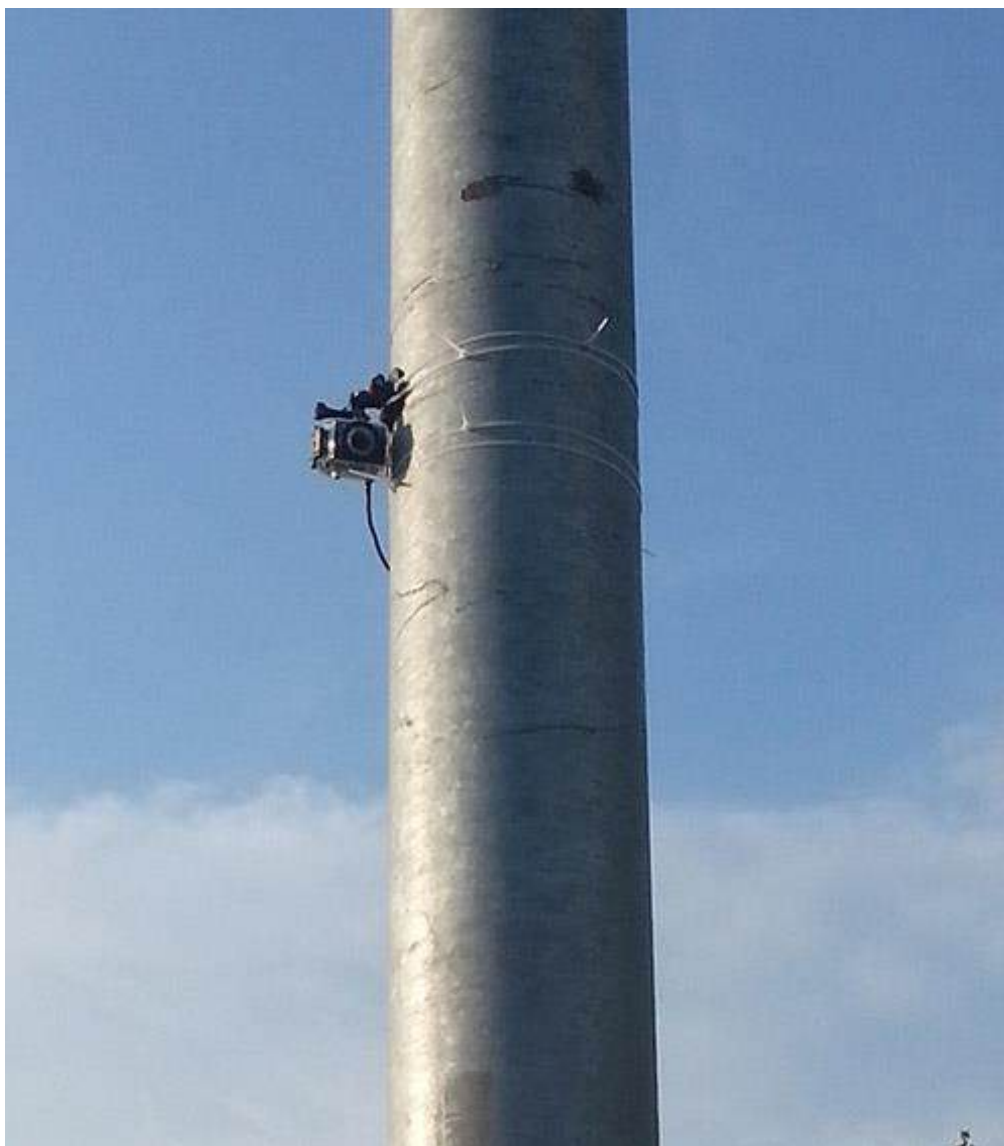
Рисунок 5 – Монтаж видеокамеры на столб линии электроосвещения
