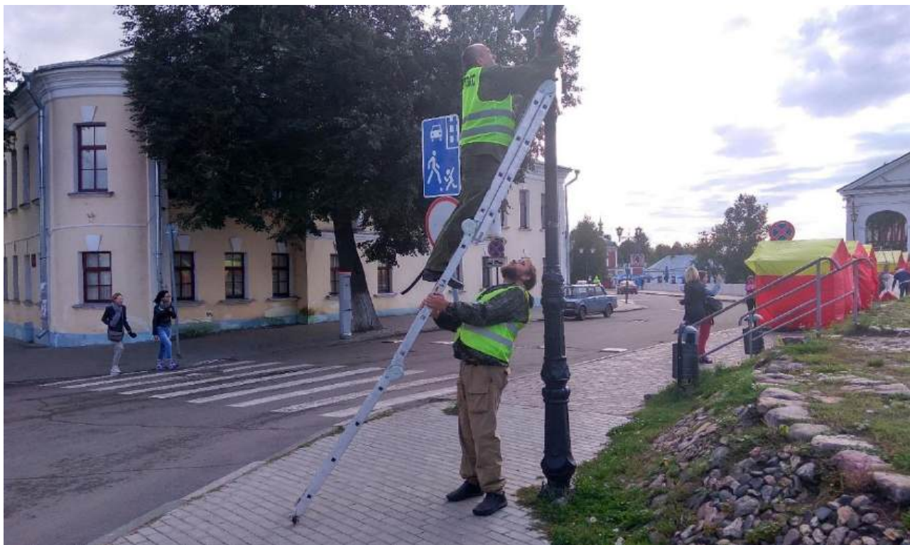
Рисунок 11 – Процесс установки камеры в точке замера
